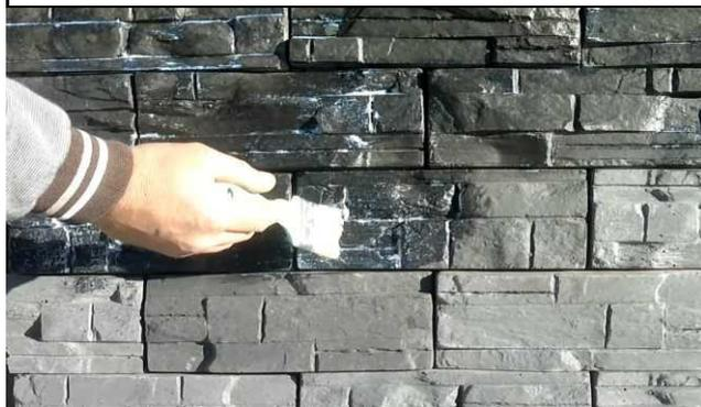
Una vez terminada la colocación, con la superficie totalmente limpia y seca, recomendamos aplicar **Hidroplastificado** acquacer para realzar el color y proteger el revestimiento de los agentes externos, siguiendo las instrucciones del envase.
